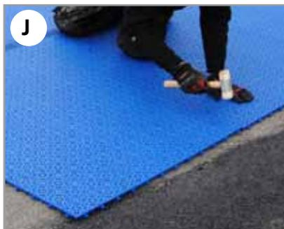
8. Setzen Sie die Verlegung der Platten entsprechend der spezifischen Zeichnung für das Feld fort. Warten Sie bei Installation innerhalb eines begrenzten Feldes mit dem Verlegen der äußersten Reihen (Bild G-H), damit diese passgenau zugeschnitten werden können.
